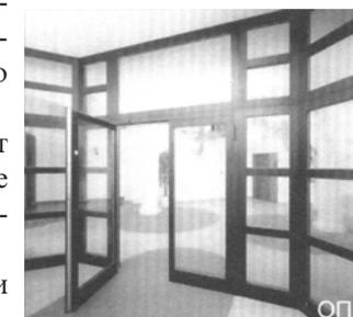
Противопожарная перегородка ОПП
