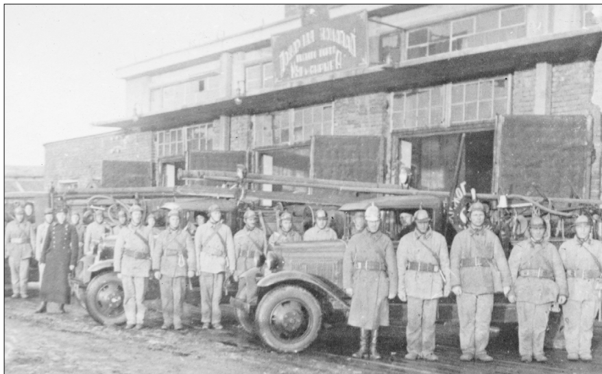
Торжественное построение пожарной команды Мурманского государственного рыбопромышленного треста «Мурманрыба» на фасаде пожарного депо на 4 выезда. г. Мурманск, 30-е годы XX века.
